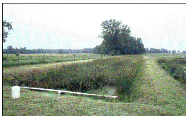
Φωτογραφία 2. Τεχνητός Υγρότοπος επιφανειακής ροής επεξεργασίας αστικών λυμάτων.
